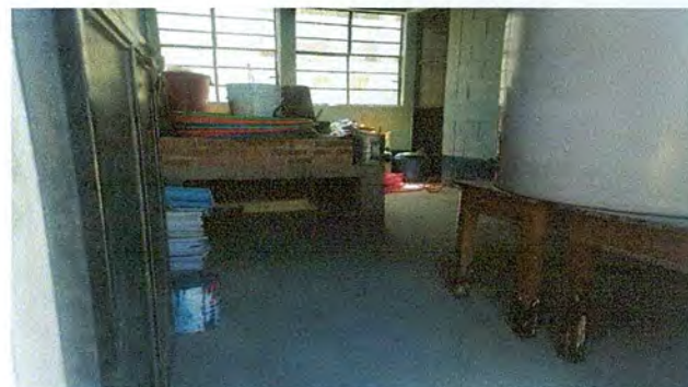
Foto 4: Mejoramiento de piso a la cocina
