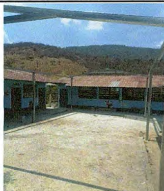
Foto 2: Mejoramiento de patio con Estructura portante a metalica (tipo portico) mas lamina troquelada calibre 26 para reuniones y actividades
