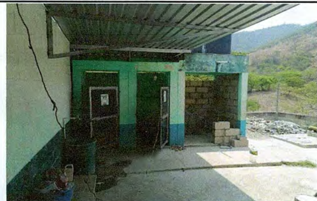
Foto 3: Mejoramiento de los servicios sanitarios.
