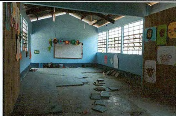
Foto 1: Mejoramiento de piso de aula polifuncional
